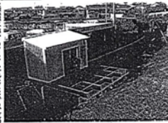
ほとんど完成がしなくなった川排水処理施設。新装置の稼働が期待されている。
