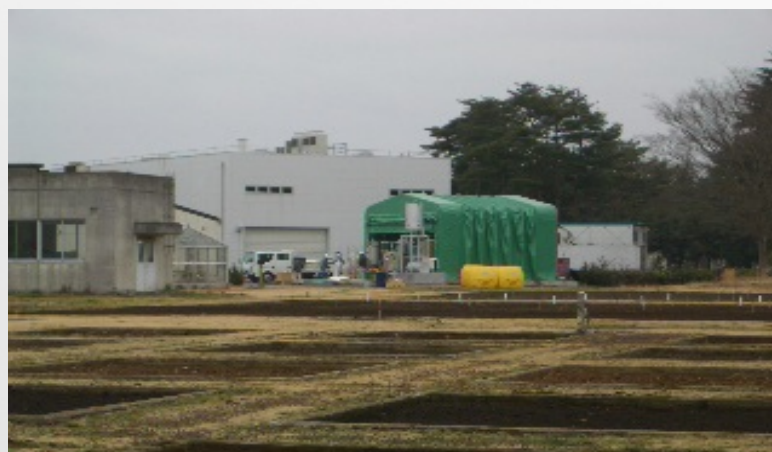
同、実験棟の全景
